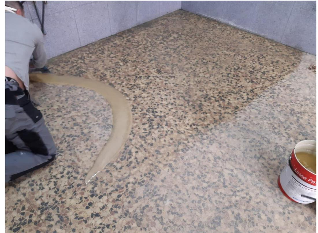
Aplicación a llana de una segunda (2ª) mano de resina epoxi 100% sólidos **Pavifer-330 + Arena Sílice** en la totalidad de la superficie a tratar. 700 gr/m<sup>2</sup>
