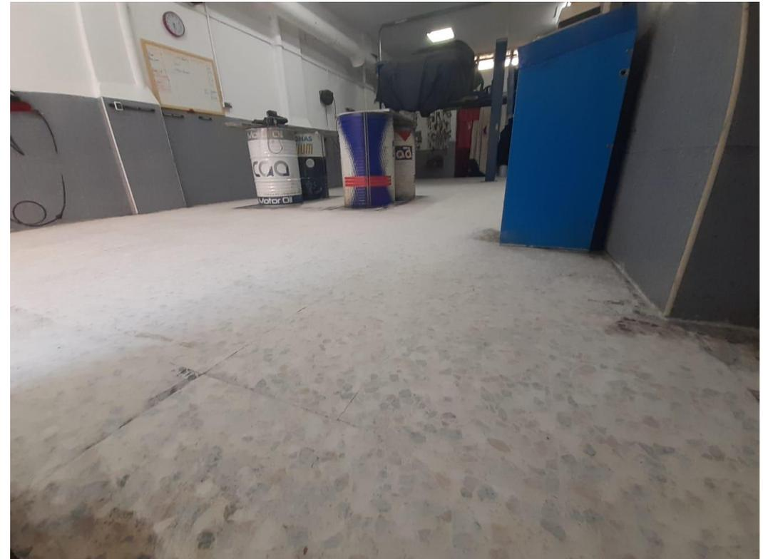
Sellado y relleno de fisuras, coqueras de toda la superficie con la aplicación de una resina epoxi 100% sólidos **Pavifer-330** + adición de **Arena Sílice** a la resina.
