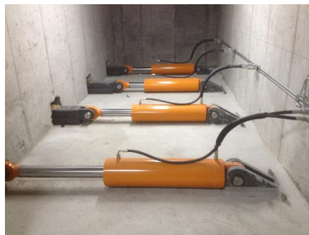
Kesselanlage mit Schubboden
