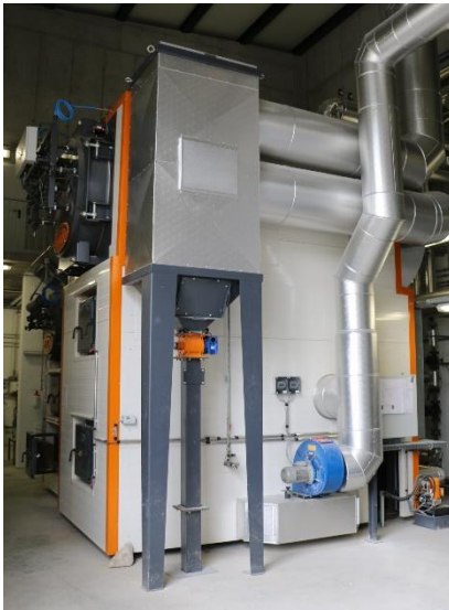
Kesselanlage mit Schubboden
