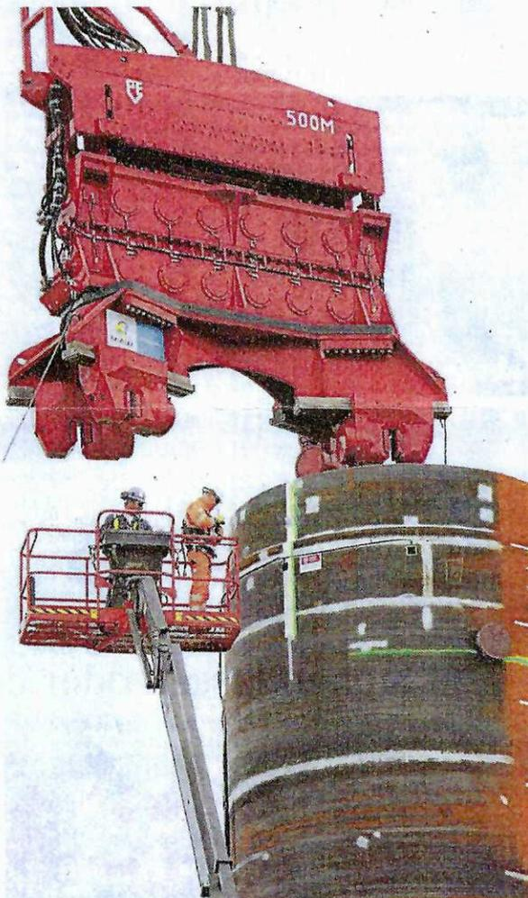
Der rote Vibrationshammer wird über den Kopf gestülpt und versetzt das Fundamentrohr in Schwingungen, wodurch es im Boden versinkt.
