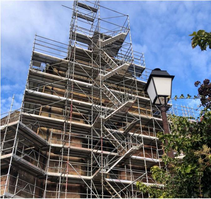
Ces travaux se font en 3 tranches sur 3 ans. Le chantier a débuté après des fouilles archéologiques menées par l'INRAP. En 2023, la restauration extérieure de la partie centrale de l'édifice a été réalisée, tant en reprise des maçonneries et pierres sur façades, des vitraux, qu'en charpente avec le remplacement intégral des couvertures des toitures, celles de la nef et celles des deux bas-côtés.
