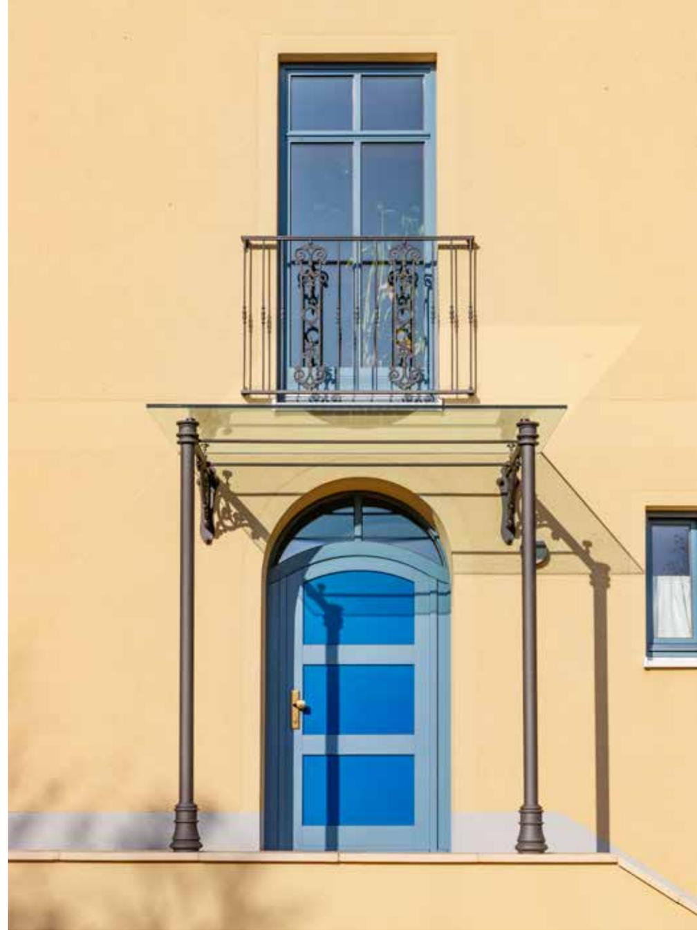
Bei Flachdächern mit großer Bautiefe oder Hauswänden mit geringer Traglast, empfehlen wir die Installation mit nostalgischen Säulen.
