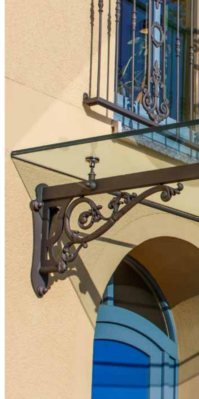
Das abgebildete Glas-Flachdach mit drei Konsolen hat eine Breite von 2.600 mm und eine Tiefe von 1.600 mm.
