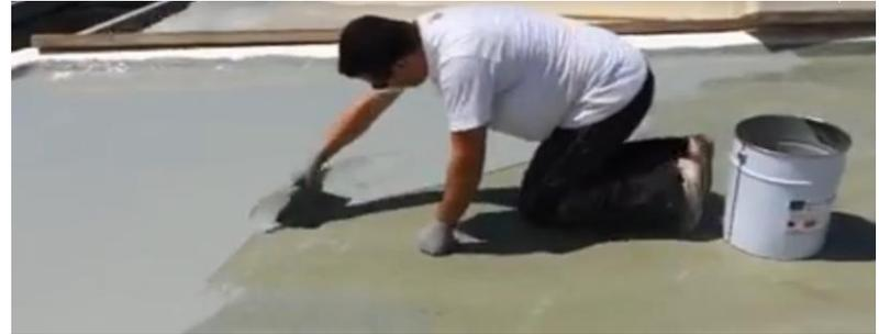
Una vez aplicados, los productos polimerizan dando lugar a un revestimiento de altas prestaciones y de excelente elasticidad en forma de capa adherida, impermeable y duradera capaz de garantizar la estanqueidad del elemento; y, lo más importante, su adaptación a la geometría de la cubierta y a la penetración de todos los puntos de difícil acceso en el logro de la impermeabilización.
