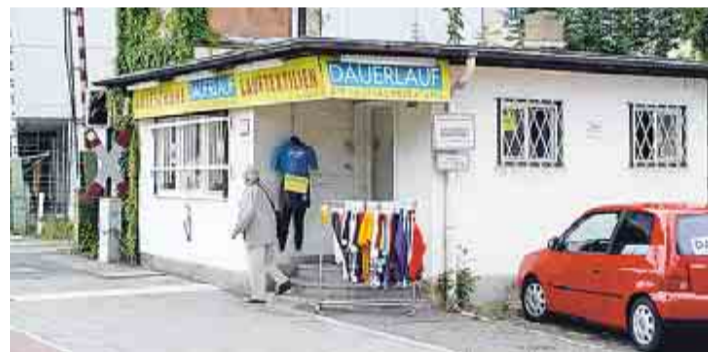
Denkmalgeschützt: Das Bahnwärterhäuschen an der Aachener Straße.
