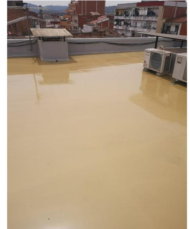
Aplicación con rodillo de una ultima mano de sellado y terminación del sistema con poliuretano alifático PU-400 Flex con una dotación de 300 gr./m2
