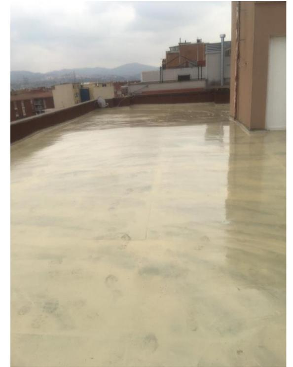
Aplicación con lana dentada de una segunda mano de poliurea en frío PS-300.EPS con una dotación de 2,0Kg. a 2,5 kg./m2
