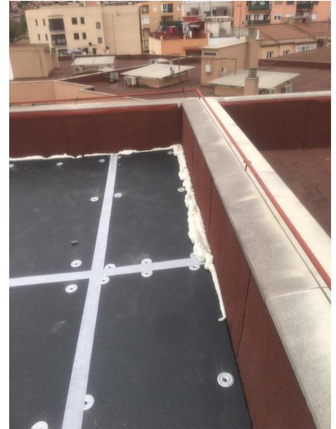
Encintado de juntas de solape entre placas de poliestireno EPS con Cinta Autoadhesiva y reforzado de puntos críticos en cubierta.
