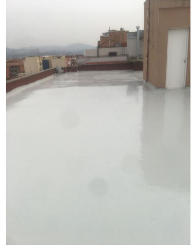
Una vez aplicada la última capa de poliuretano alifático flexible **PU-400 Flex** con un consumo de 300-400 gr/m<sup>2</sup> en 24 horas ya es totalmente transitable para tráfico intenso.
