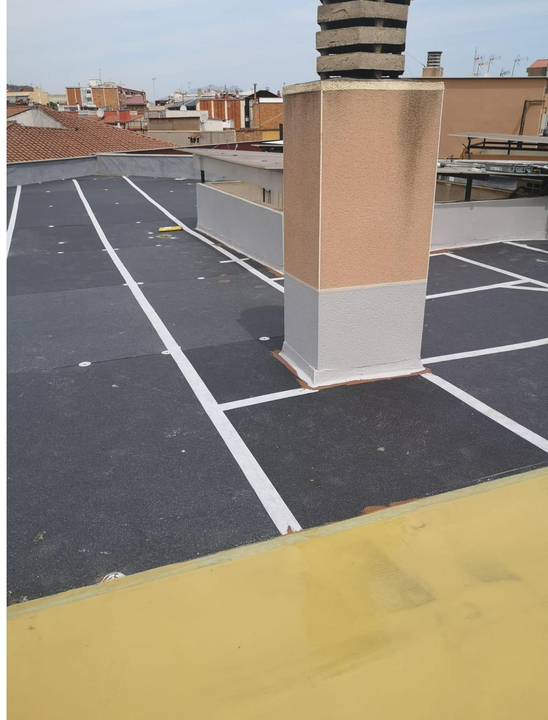
Limpieza general de toda la superficie y colocación de placa de poliestireno EPS de Densidad D/35 y 6 cm de espesor anclada mecánicamente al soporte.
