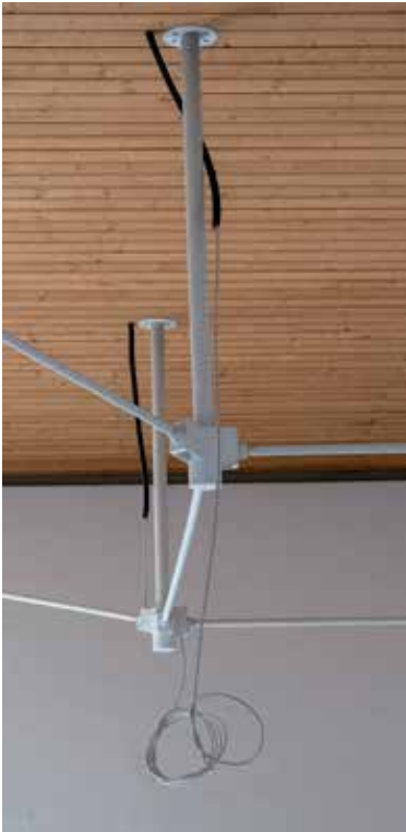
Die Anschlüsse für die neuen Deckenleuchten sind vorbereitet.
