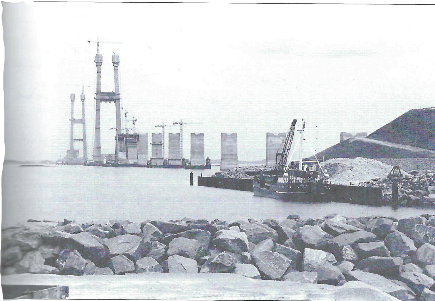
Brückenbaustelle über den großen Belt
