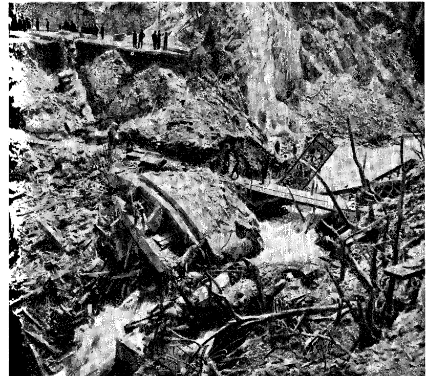
Bild aus dem Zweiten Weltkrieg. Westfeldzug. Von den Franzosen in den Westalpen gesprengte Strassenbrücke.
