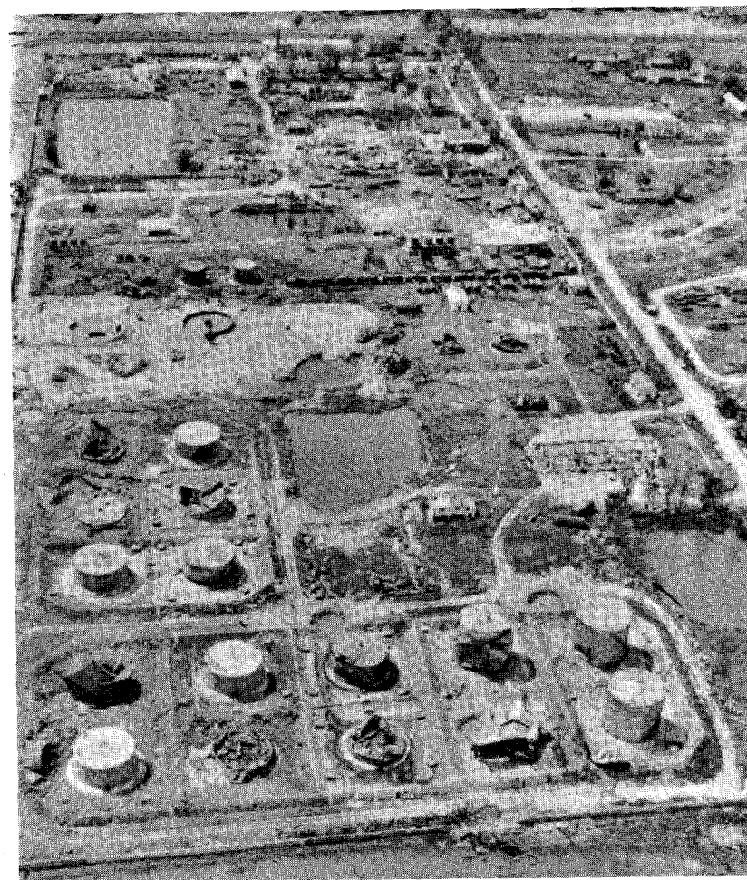
Betriebsstoffanlage (Überflur-Tankanlage) nach einem Luftangriff. ▲
