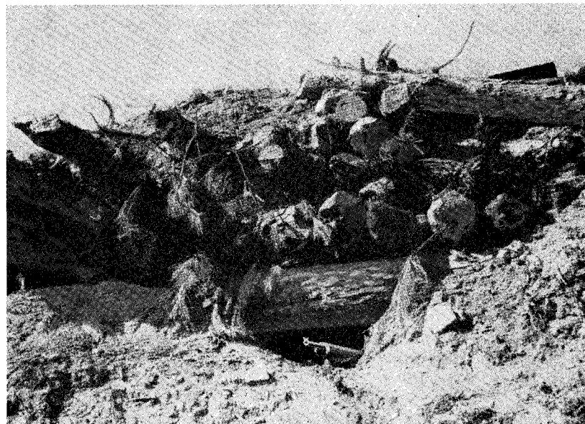
Scharte der überdeckten Waffenstellung nach dem Beschuss! Beachte die materielle Wirkung des Vorbereitungsfeuers: Rundholz der Überdeckung verschoben. Scharte durch Erde teilweise verschüttet. Die Waffenstellung ist als Ganzes gesehen noch intakt und muss infanteristisch niedergekämpft werden.
