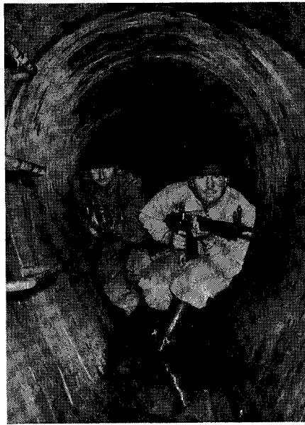
Kanalisationsrohr. Eiprofil. Durchmesser 120 cm
