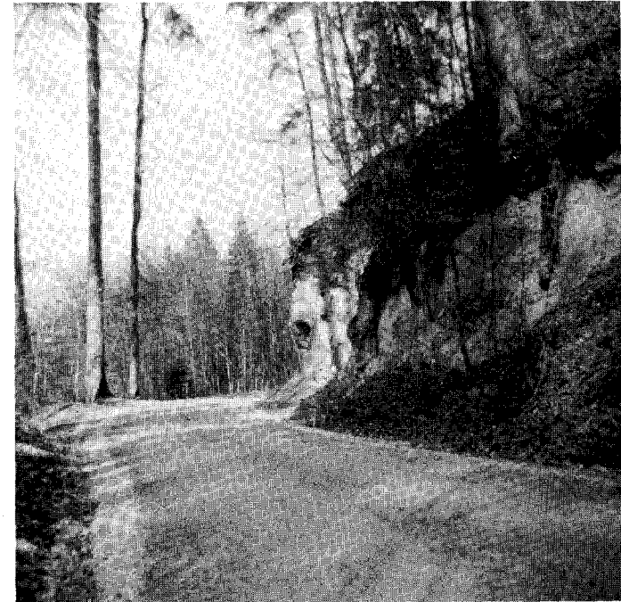
Zerstörungen an der Zweitklass-Strasse, welche aus dem Flusstobel auf das Plateau führt. Blick auf die Sprengstelle Nr. 2. Die Naturstrasse wird zwischen Felswand und Steilhang auf eine Länge von ca. 10 m abgesprengt. Verteidigung der Zerstörungsstelle beziehungsweise Verhinderung der Wiederinstandstellungsarbeiten: Artillerie-, Minenwerfer- oder Gewehr- Stahlgrenatatenfeuer.
