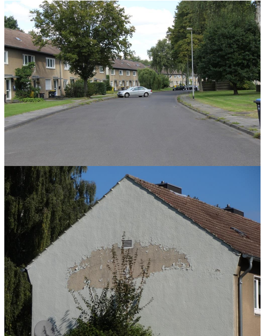
Abb. 67: Mangelnde Vielfalt im Wohnraumangebot und hohe Sanierungskosten als Risiko
