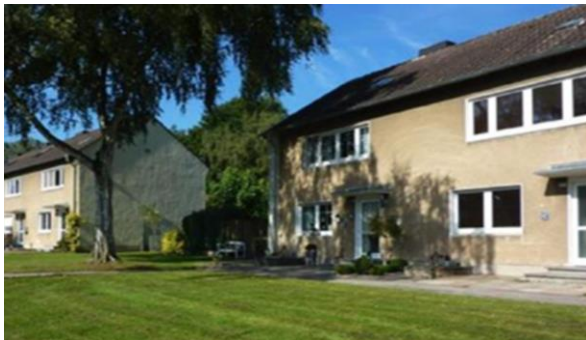
Abb. 74: Bestandsgebäude – Einrichtung Musterhaus im nördl./östl. Siedlungsteil Quelle: Planungsgruppe MWM / reicher haase assoziierte GmbH 2016
