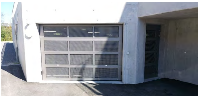
Tiefgaragen - Sektionaltore
