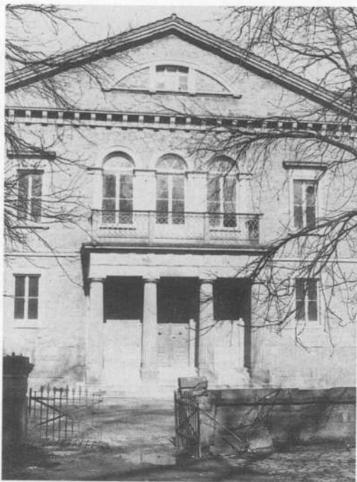
Der Mittelrisalit des alten Schulhauses
