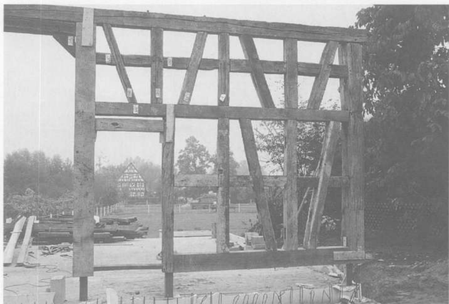
Blick durch das Fachwerk der Museumsscheune auf das Fachwerk des Pfadfinder-Hauses Fotos: Klaus Eichenlaub
