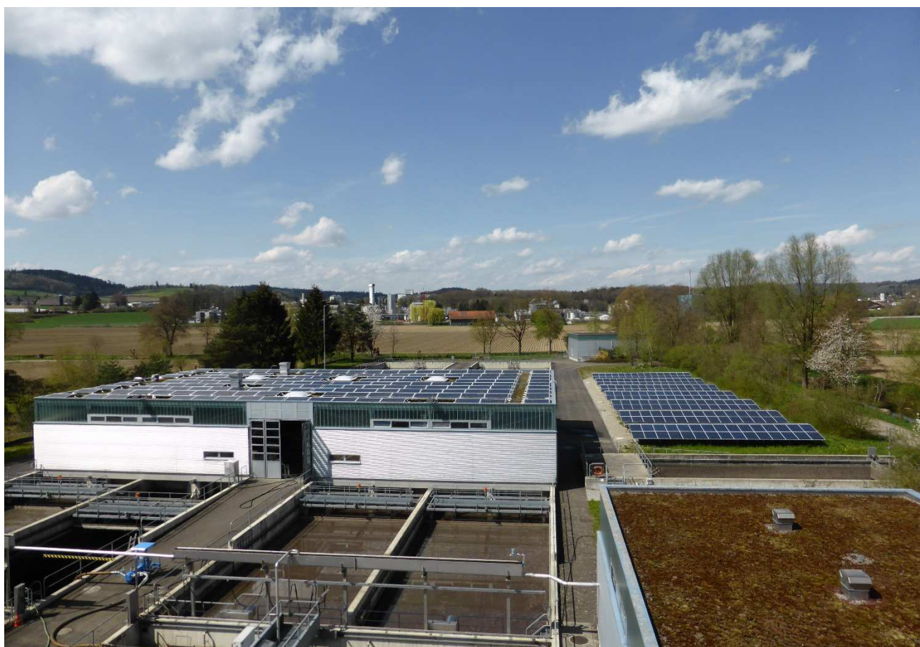
Blick auf die gesamte Photovoltaikanlage
