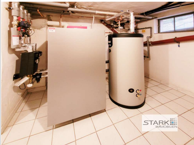
UG Heizung neu
