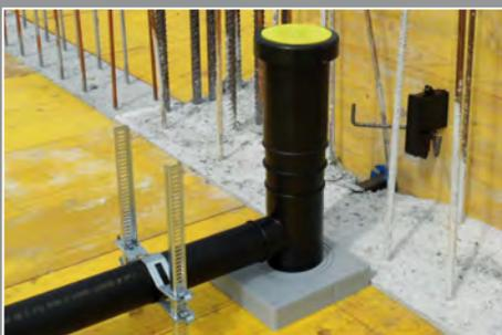
Saubere Aussparung für die Montage der Fallstränge ohne Beschädigung der Schalungsbretter.
