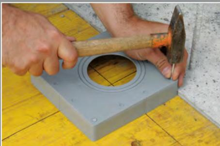
Gewünschte Lochdimension ( $\varnothing$  50 bis 125 mm) ausschneiden und mit Nägeln befestigen.
