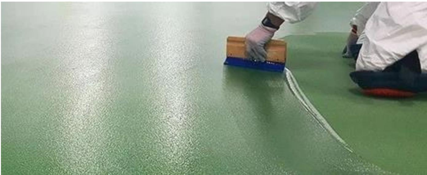
Recubrimiento epoxi 100% sólidos de medio espesor con textura de acabado lisa o antideslizante para sollicitaciones mecánicas bajas-medias.
