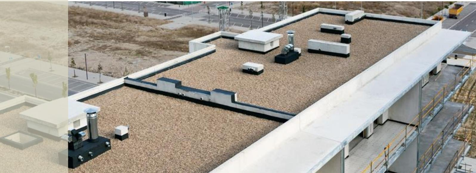
Impermeabilización de cubierta transitable mediante la aplicación de membrana líquida de aplicación in-situ.
