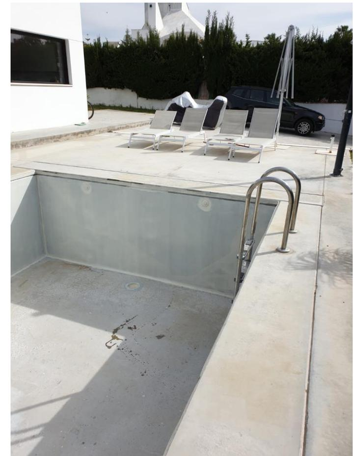
Aplicación a rodillo de una segunda (2ª) mano de membrana a base de poliurea en frío **PS-300.D** en la totalidad de la superficie a tratar. 400 gr/m<sup>2</sup>
