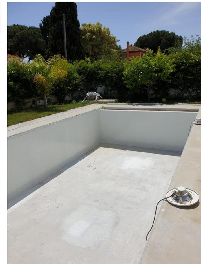
Aplicación a rodillo de una tercera (3ª) mano de membrana a base de poliurea en frío **PS-300.D** en la totalidad de la superficie a tratar. 400 gr/m<sup>2</sup>
