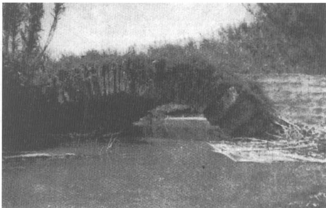
Puente de los Mozos visto desde otra perspectiva
