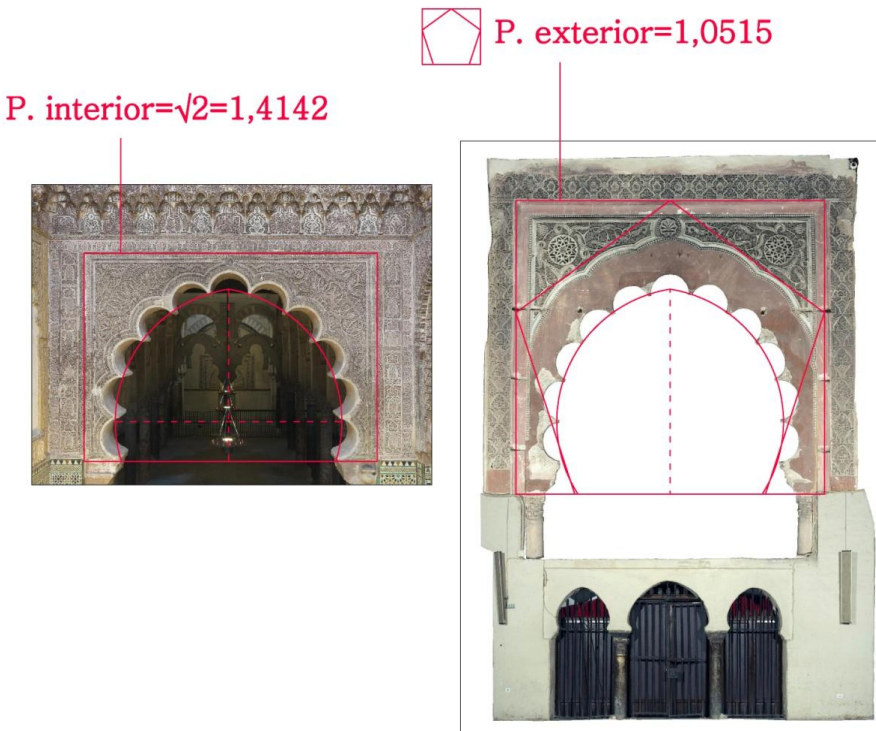
Fig. 26. Capilla Real de la Mezquita de Córdoba, siglo XIV, arco sur de la Capilla visto desde el interior de la misma y visto desde el exterior, desde la nave 13. A la pregunta ¿existió la geometría y la proporción como instrumento de trabajo del arquitecto medieval? esta capilla Mudéjar nos evidencia en este arco, coetáneo por ambas caras en la fecha de construcción de la capilla, dos imágenes y dos proporciones muy diferentes: una la vista desde el interior, con la proporción "diagonal" [ P=\sqrt{2}=1,4142 ] y otra para la vista desde el exterior con la proporción [ P=1,0515 ].
