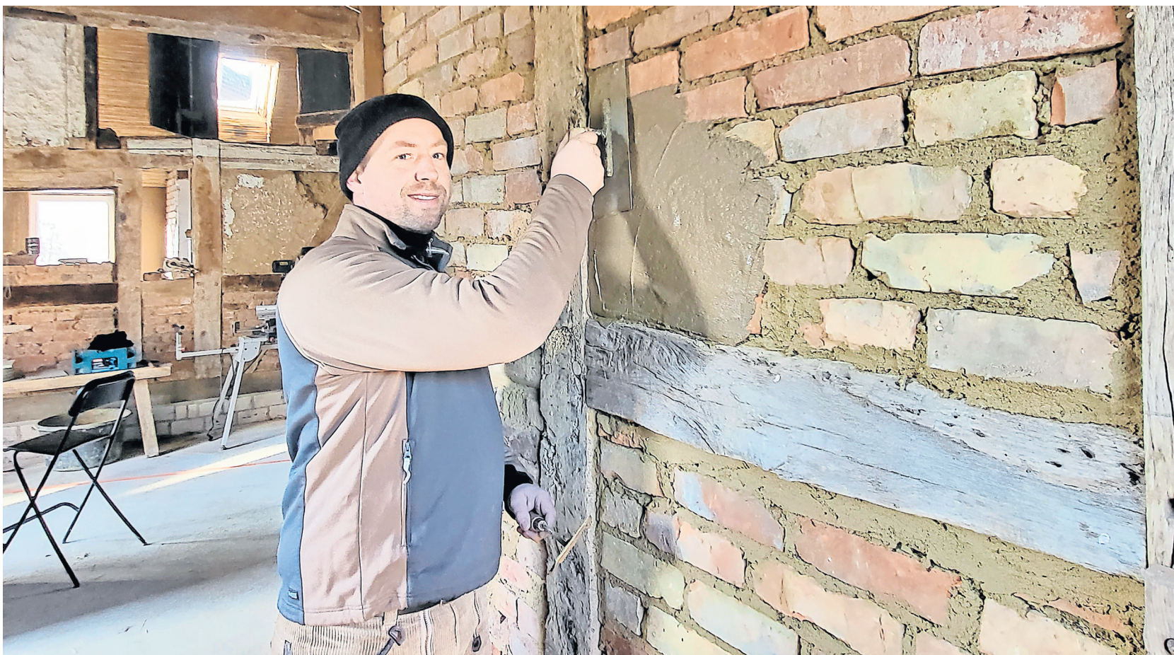
Andreas Otto putzt die Gefache in seinem Haus auch mit Lehm vom eigenen Grundstück.
