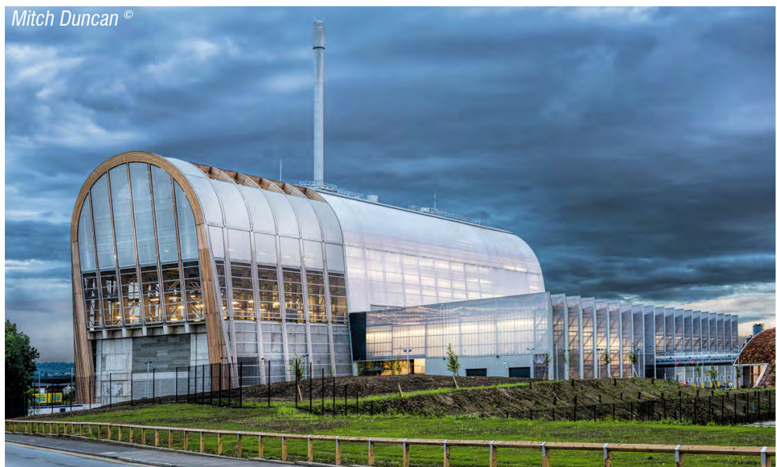
Architectes: S'PACE architects - Jean Robert MAZAUD / Consultant AMOE BREEAM®: S'PACE Environnement
