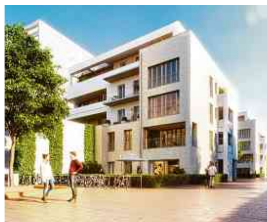
Wie ein Kranbau liegt das Wohnhaus auf dem Tunnel
