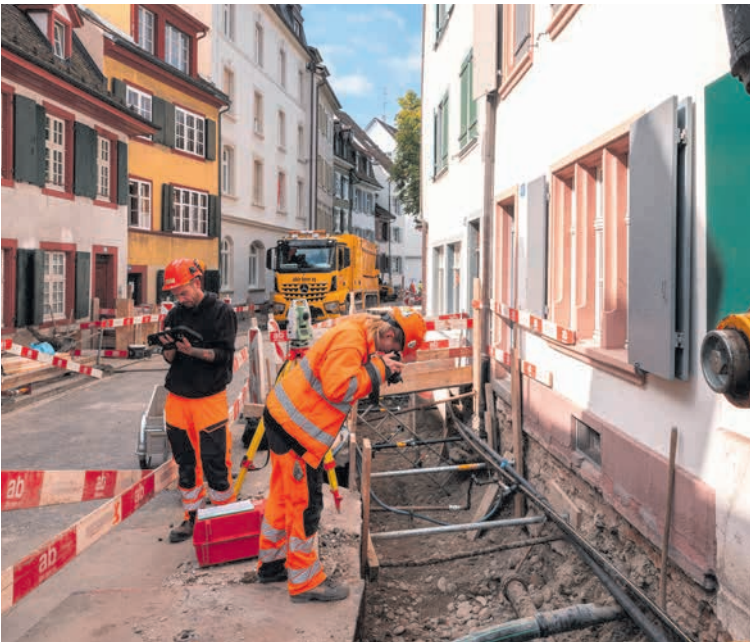
Bauarbeiten Lindenberg. (Bild: Philippe Saurbeck, Archäologische Bodenforschung Basel-Stadt)
