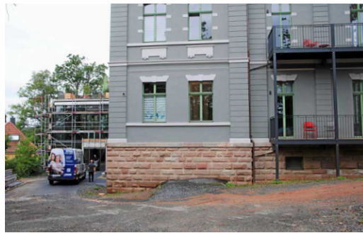
Der Eingangsbereich der neuen Senioren-Residenz. Die Außenanlage muss noch gestaltet werden.
