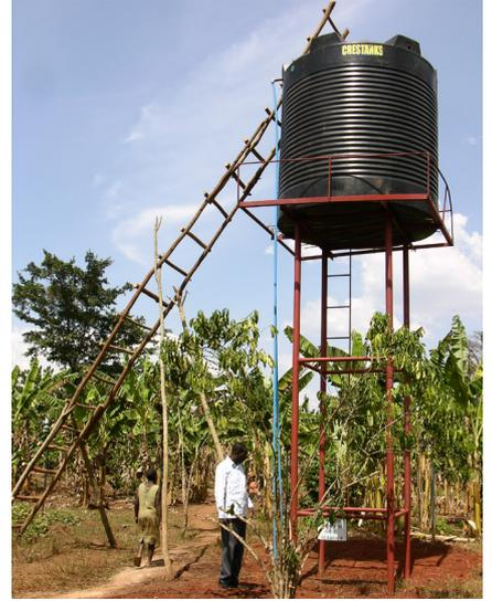
Wasserturm mit 10'000 Liter Tank für die Grundwasserpumpe mit 55 l/Min
