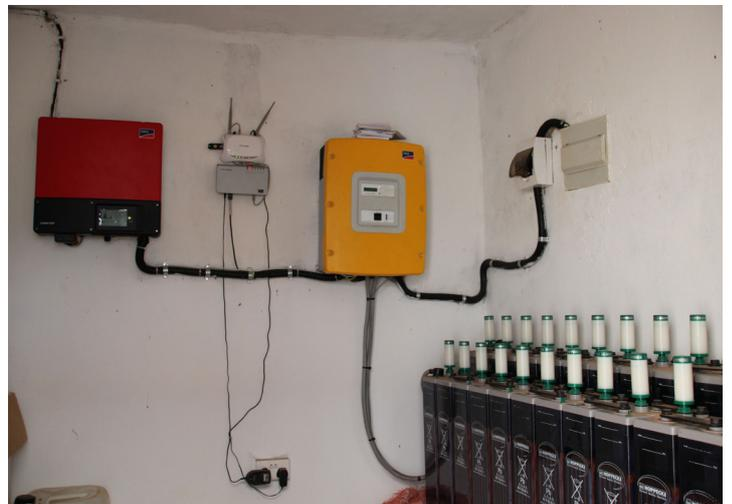
Für die SMA Wechselrichter und die 24 Hoppecke 6 OPZS Batterien wurde ein kleines Gebäude (Powerhouse, Bild links) errichtet.
