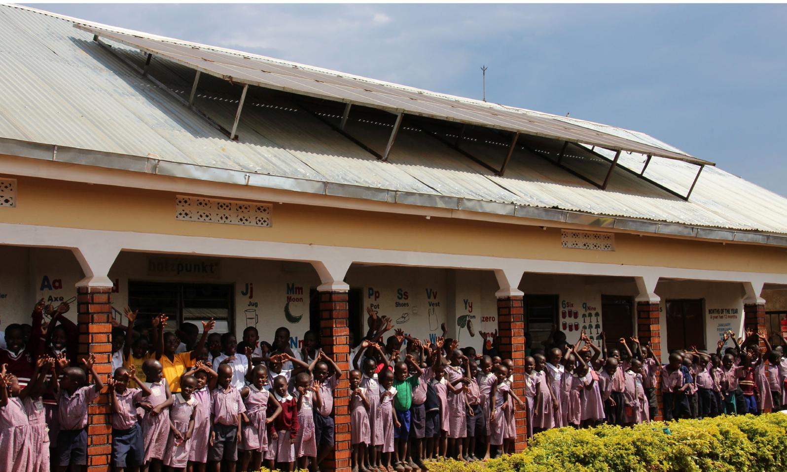
Der Sonnenstand am Äquator wechselt halbjährlich  $\pm 23.3^\circ$ . Deshalb wurden die PV-Module nur  $10^\circ$  geneigt.
