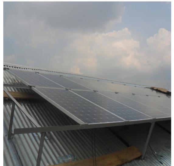
Die Anfertigung der Tragkonstruktion für die Solarmodule erfolgt mit einfachsten Mitteln vor Ort
