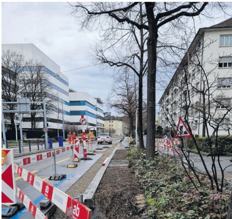
Baustellen-Kulisse: In der Wettsteinallee werden 32 Parkplätze aufgehoben. Das gefällt dem NQV Oberes Kleinbasel gar nicht. (Bild: D. Seiler)
