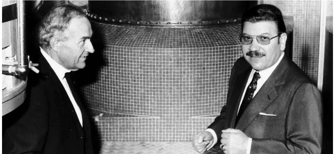
Hans Jakob Nidecker (rechts) mit Bauingenieur Otto Binding begutachten die neue Sudpfanne. (Bild: zVg)
