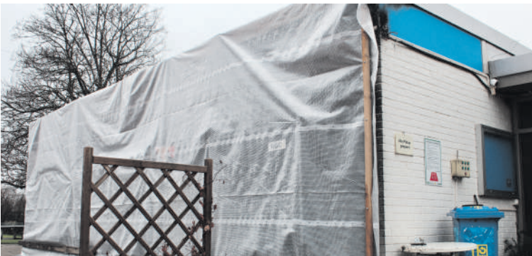
Wegen des Brandes musste das Clubhaus in eine Schutzhülle eingepackt werden. (Bild: Armin Faes)
