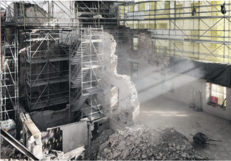
Die Baustelle während des zweiten Abbruchs. (Bild: Annette Fischer)
