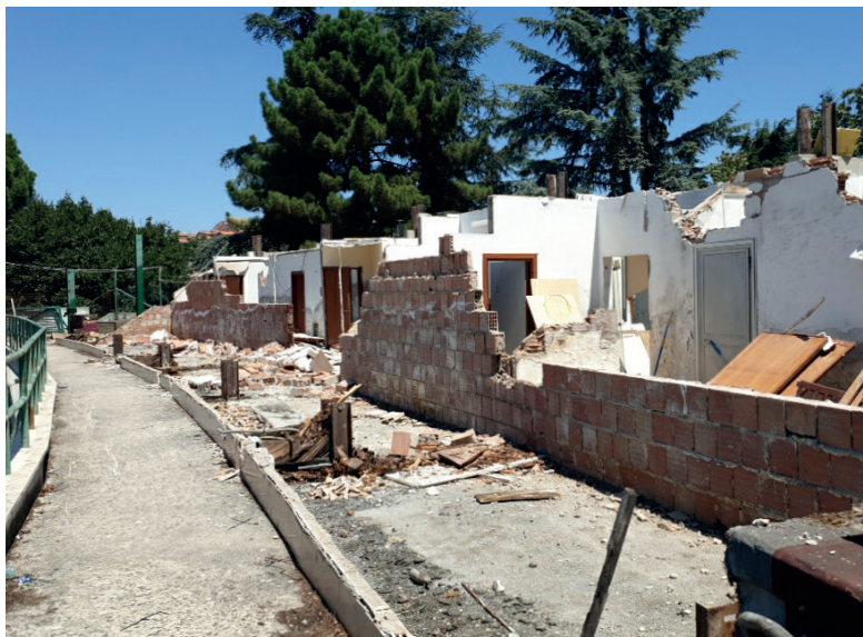
Lavori di messa in sicurezza allo Stadio "Domenico Fiore - Italia '90"
