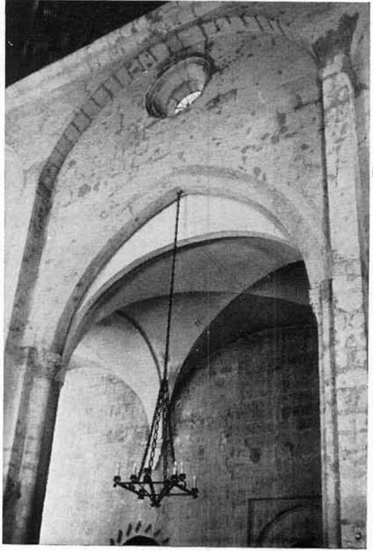
Muro armado de la nave central
