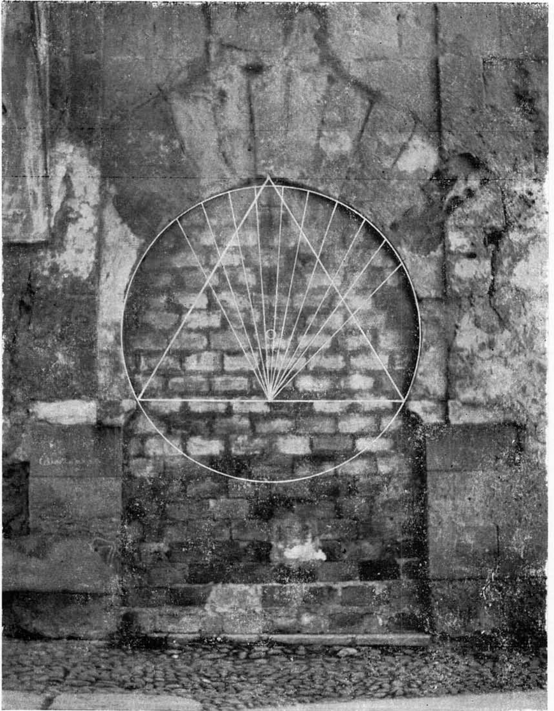
Arco de entrada desde el exterior, al recinto murado
