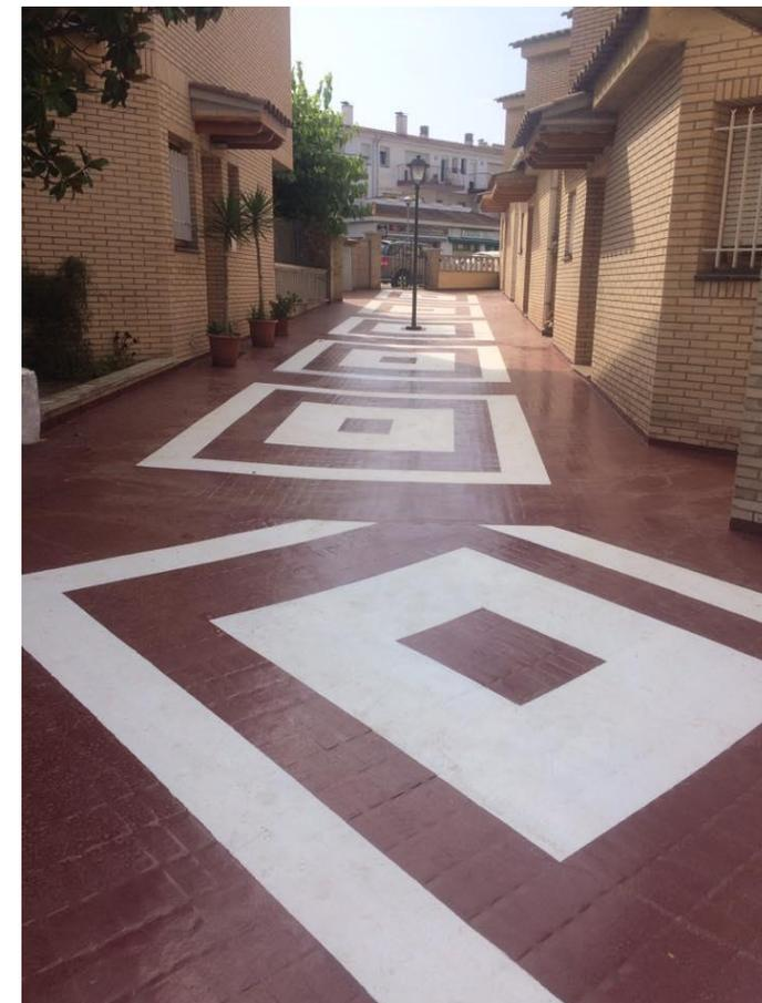
Una vez aplicada la última capa de poliuretano alifático flexible **PU-400 Flex** con un consumo de 300-400 gr/m<sup>2</sup> en 24-48 horas ya es totalmente transitable, incluso a tráfico rodado.
