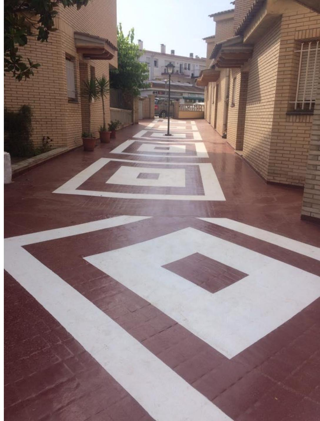
Limpieza general de toda la superficie y aplicación de una primera mano de imprimación base epoxi 100% sólidos **Primer PS-022** en la totalidad de la superficie a tratar. 250 gr/m<sup>2</sup>
