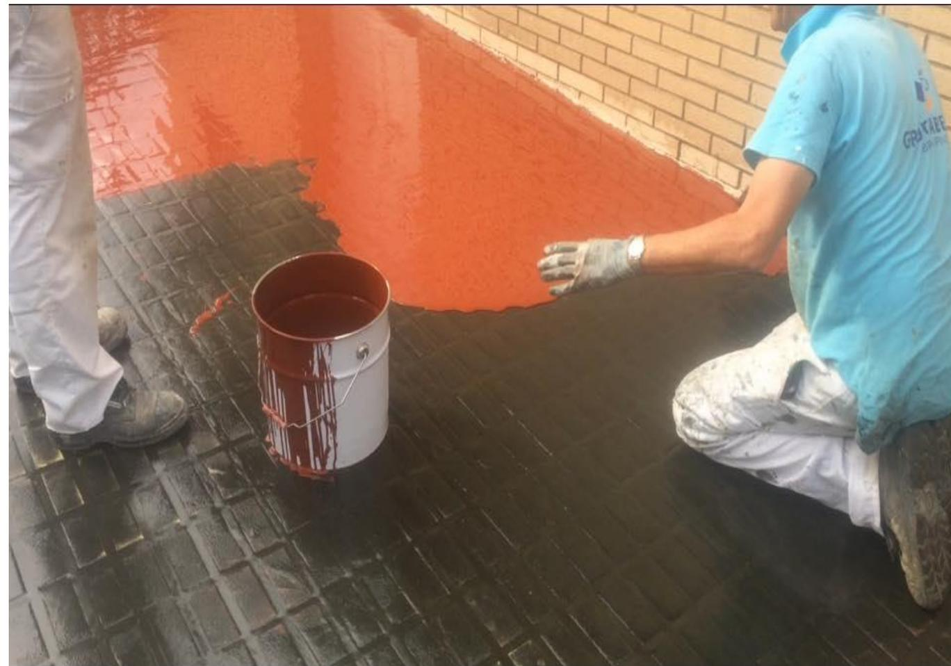
Aplicación a rodillo de una tercera (3ª) mano de pintura de poliuretano flexible **PU-400 Flex** en la totalidad de la superficie a tratar. 400 gr/m<sup>2</sup>
