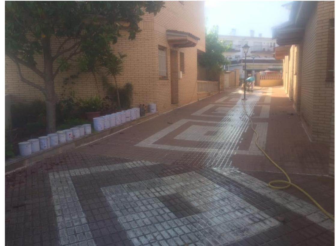
Aplicación a labio de goma de una primera (1ª) mano de membrana a base de poliurea en frío **PS-300.E + GomaCaucho** en la totalidad de la superficie a tratar. 1.700 Kg./m<sup>2</sup>
