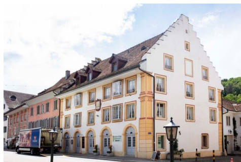
Gasthaus Zur Waag, Bad Zurzach
