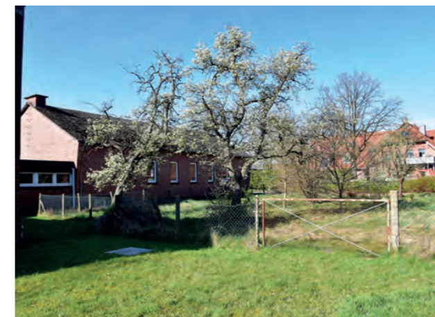
Abb. Gemeindehaus Toppenstedt
