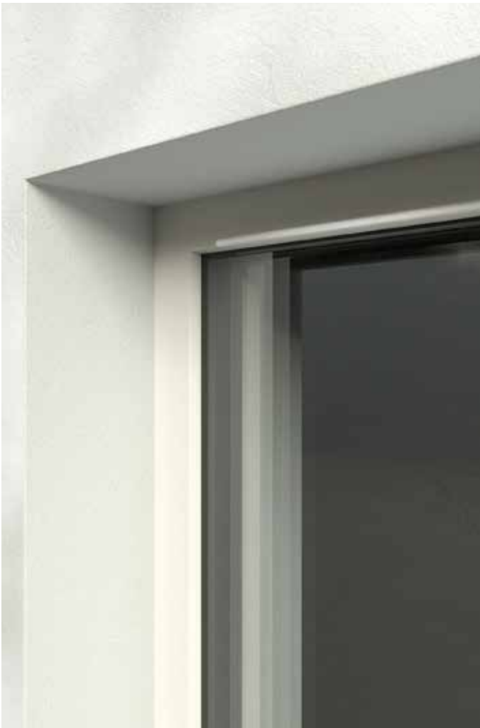
sichtbarer Einbau des Blendrahmens
