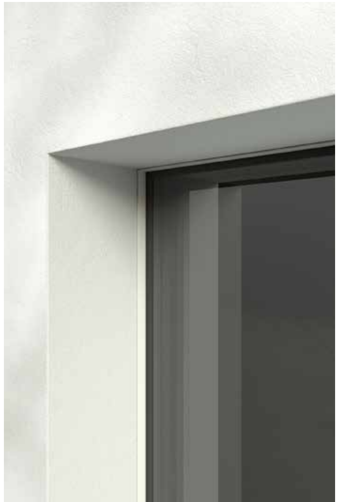
verdeckter Einbau des Blendrahmens
