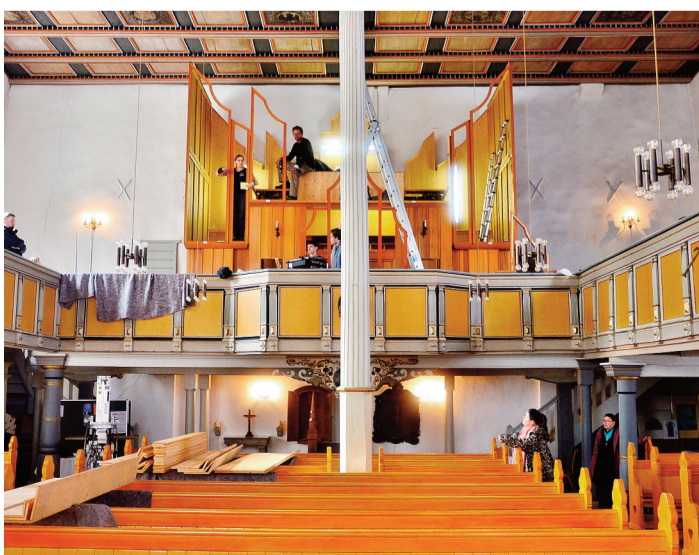
Baustelle in der Kirche St. Aegidien.
