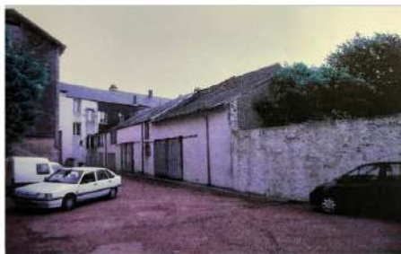
avant les démolitions...
