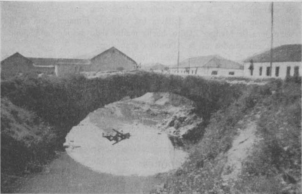
Otro costado del puente del camino de Burriçiegos
