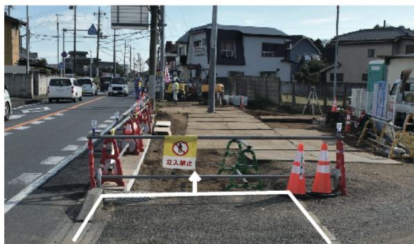
歩道の延伸工事
