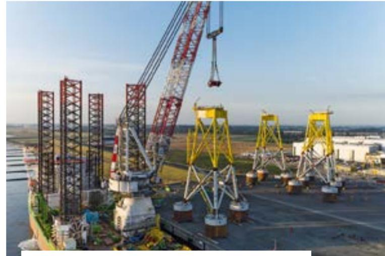
Die Suction-Bucket-Jacket-Fundamente werden im Hafen auf die Installationsschiffe verladen.
