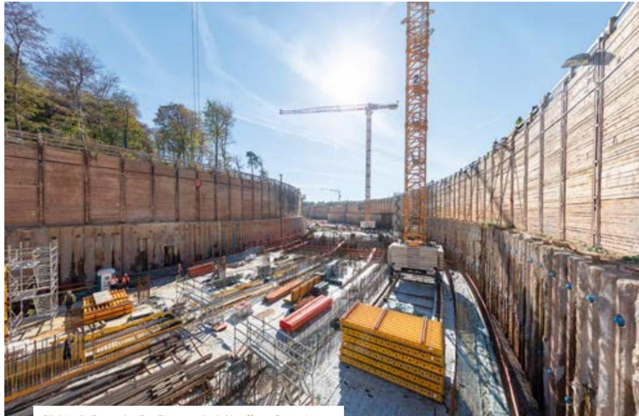
Blick in die Baugrube: Der Ringtunnel wird in offener Bauweise erstellt. Die präzise eingebauten Fundamentblöcke des Ringtunnels tragen die Lasten des Tunnels und der Einbauteile ab.
