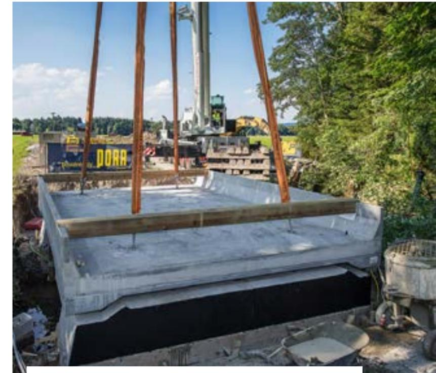
Die Widerlager der alten Brücke konnten aufgrund des geringen Eigengewichts des neuen Brücken-Fertigteils aus UHPC beibehalten werden.
