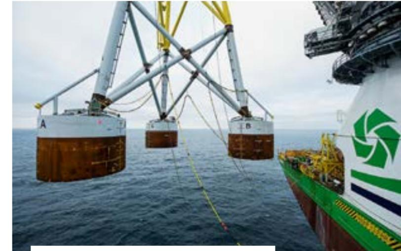
Die dreibeinige Jacket-Struktur mit den Becherfundamenten wird im Meer versenkt.
