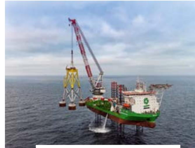
Installation eines Jacket-Fundaments mit Suction-Bucket-Podesten
