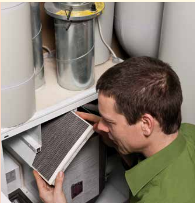
02 Filterwechsel an der Lüftungsanlage
