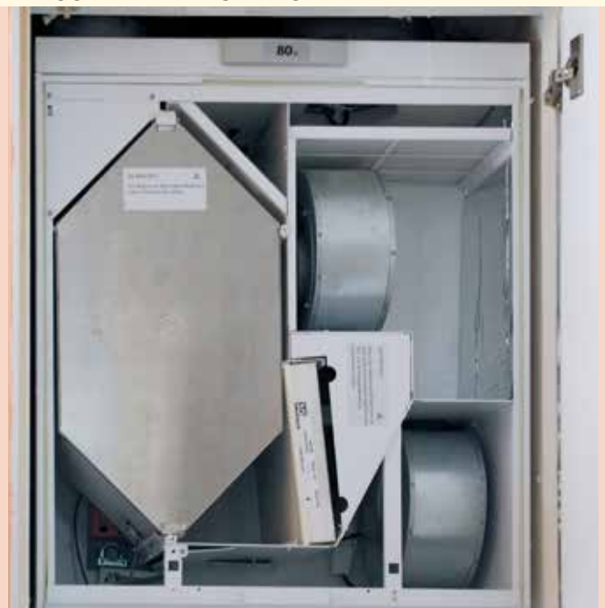
Lüftungsgerät mit Wärmerückgewinnung
