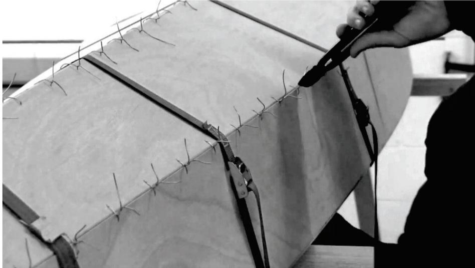
*Abbildung 34: Seiten- und Bodenplanken werden mit Kupferdraht vernäht.*
