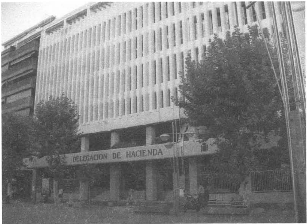
Foto nº 20. Actual edificio de la Delegación de Hacienda.
