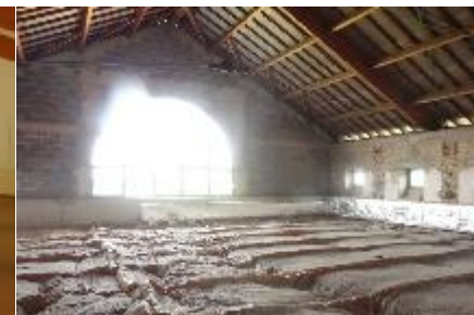
Premier étage de la piscine
