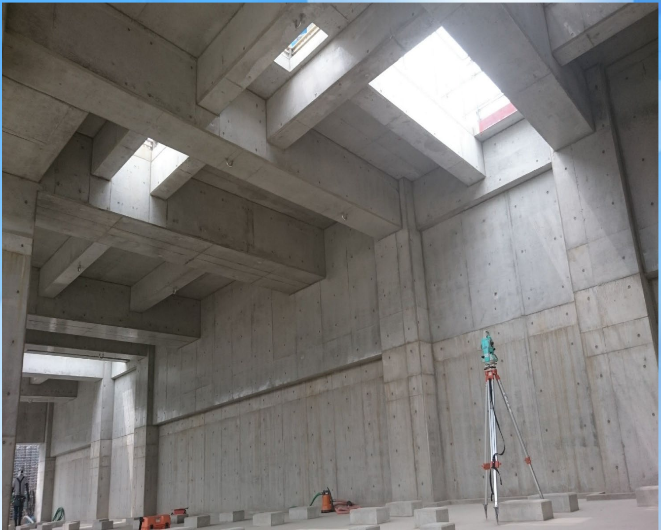
ごみ焼却場建設工事における鉄筋コンクリート造(RC造) 地下1階の壁・梁・スラブ型枠取り外し後の様子
