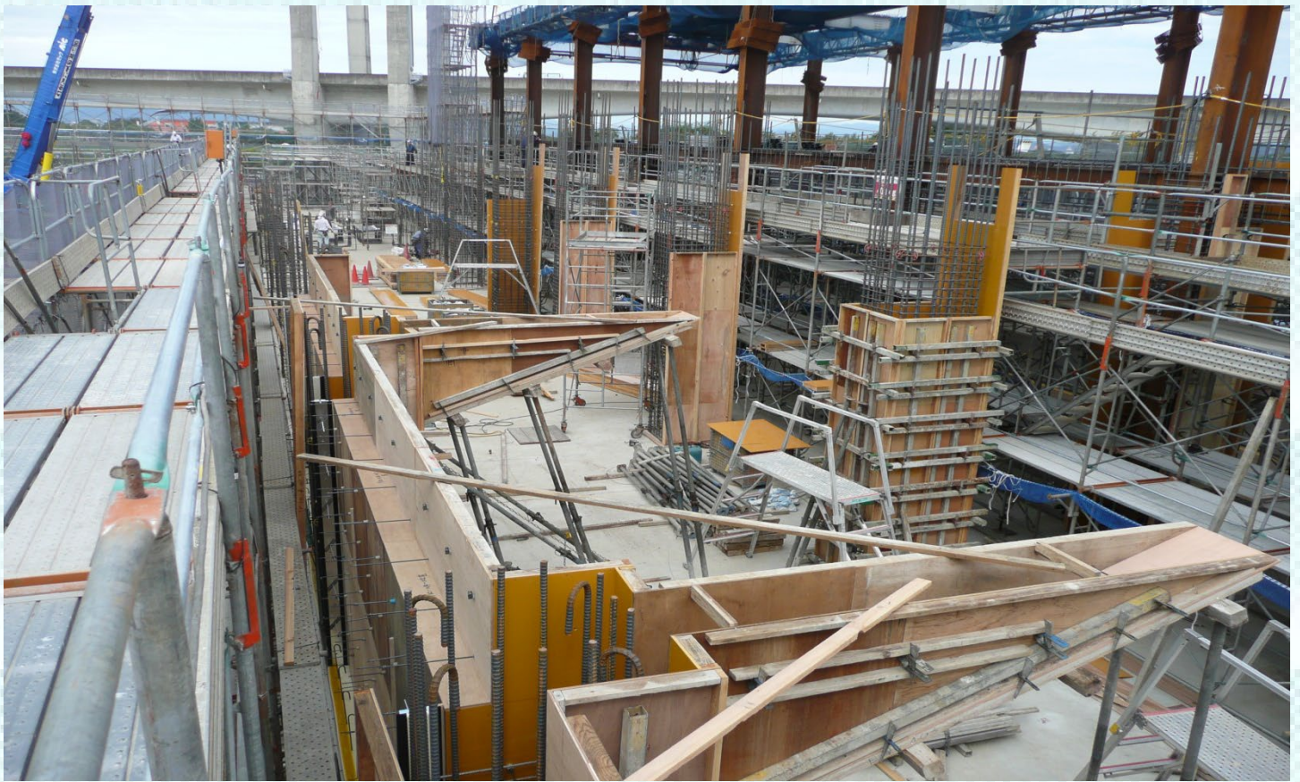
体育館新築工事における鉄筋コンクリート造(RC造)部分の 型枠建込の様子
