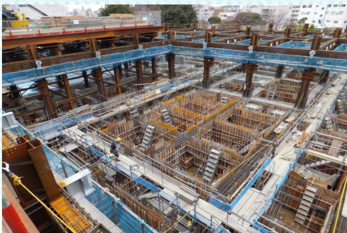
鉄骨鉄筋コンクリート造(SRC造)建物の型枠建込の様子
