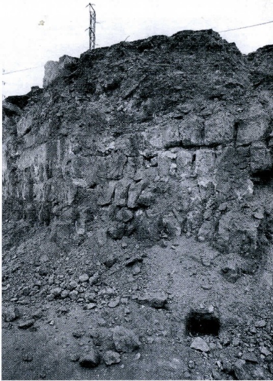
Parte de la muralla del alcázar de la almunia de La Noria hallado junto al vado de Casillas.
