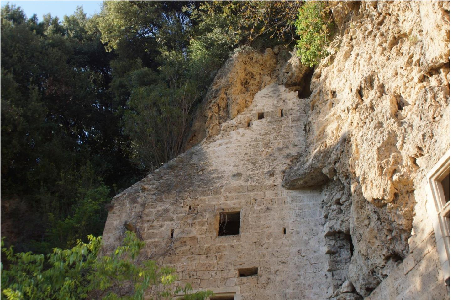
En ressortant on voit l'imbrication de la construction avec le tuf, la construction est d'ailleurs faite en moellons taillés dans le tuf. On distingue également les meurtrières qui protégeaient l'entrée, les 3 ouvertures tout en haut correspondent également à une petite salle de guet très difficilement accessible.
