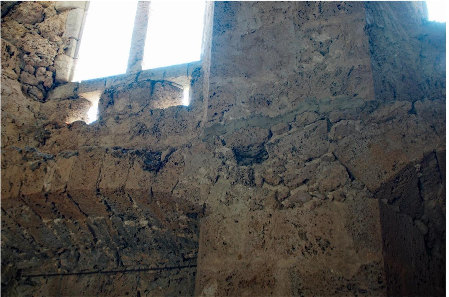
Sous la fenêtre on voit l'emplacement des poutres pour maintenir un plancher et ci-dessous dans une des pièces le conduit d'une cheminée qui permettait de la chauffer...
