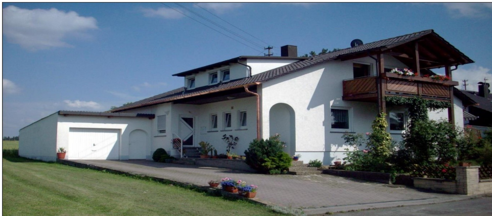
Nordwestansicht (Quelle: Auftraggeber)
