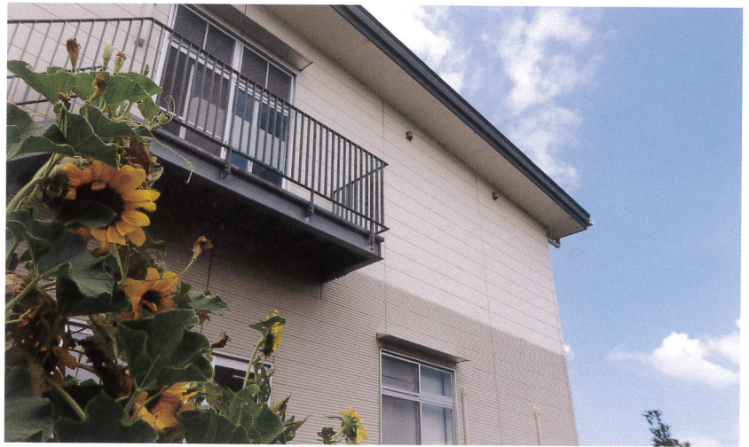
非常階段下の花壇から
