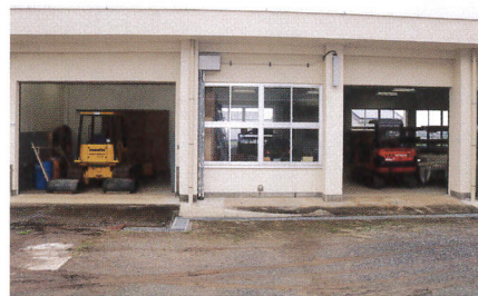
土木施工実習室（土木科）
