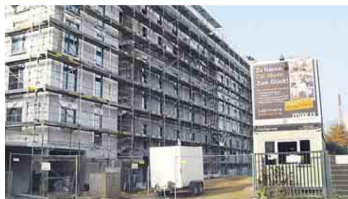
101 Mietwohnungen entstehen an der Max-Wallraf-Straße.
